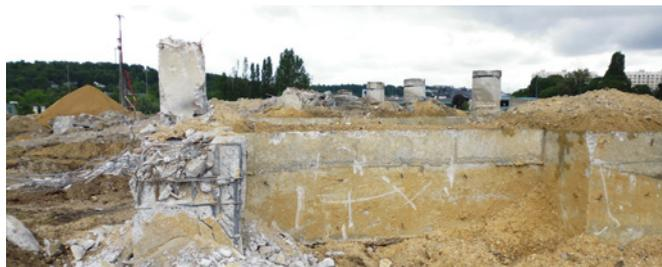
Les fondations de l'usine sont dégagées : ici, côté Boulogne, on distingue la structure construite en 1984 pour supporter les installations de la tôlerie de l'Express.
